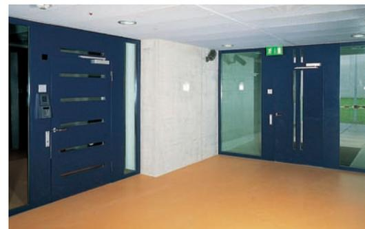
Sendo frequentemente utilizadas em caminhos de fuga, é muitas vezes necessário ligar as construções a sistemas de monitorização e alarme. Para atender a essas exigências, os perfis Janisol C4 são fornecidos, de série, com canal de cabos, que permite uma ligação elétrica fácil e segura – também numa fase posterior, quando necessário.
