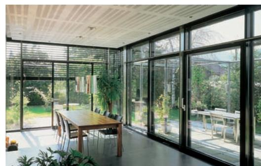
Com uma largura visível de apenas 50 mm e uma forma que se vai reduzindo no sentido do interior, os perfis distinguem-se por um aspecto particularmente leve e elegante. Diferentes reforços integrados no espaço vazio dos perfis, que podem ser adaptados às necessidades individuais, ampliam as opções construtivas para a criação de fachadas de aço claramente estruturadas. Os sistemas baseiam-se numa tecnologia testada e podem ser combinados com as comprovadas estruturas VISS.
